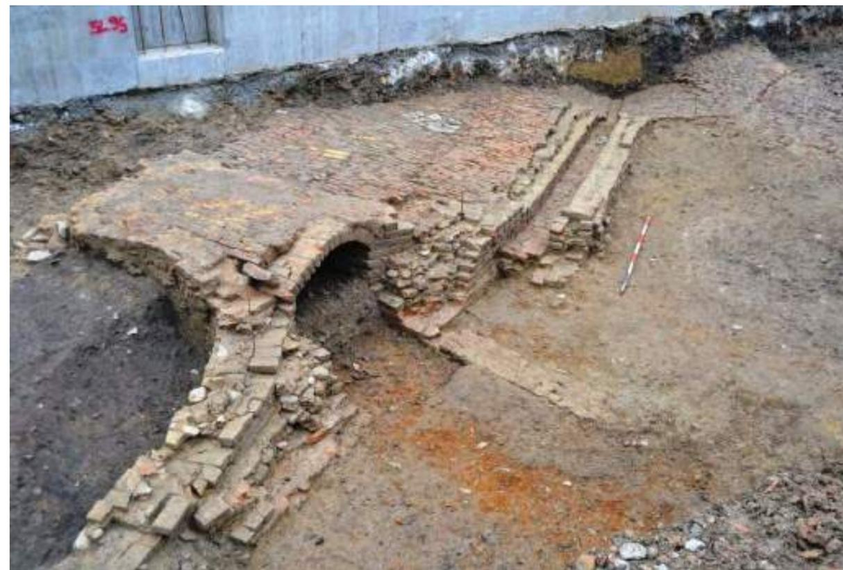
Fig. 16. Piazza della Vittoria, condotta fognaria in mattoni coperta da volta a botte.
